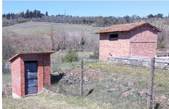
Figura 8 - Rifacimento recinzione esterna
