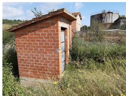
Figura 2 - Locale ingresso sollevamento in uso
