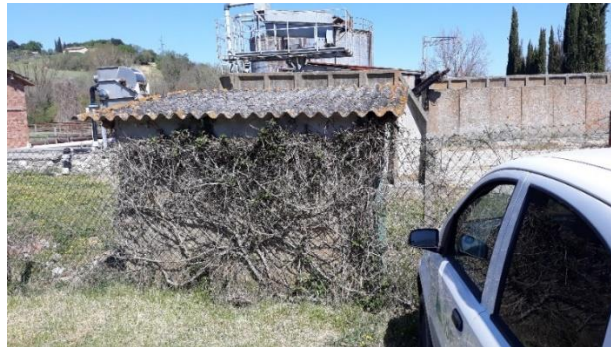
Figura 1 - Magazzino in disuso
