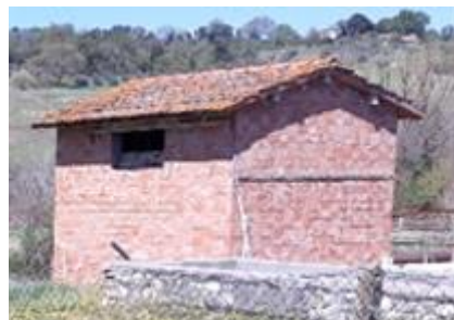
Figura 5 - Locale compressori in uso
